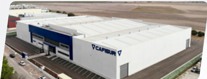
Werk für Blechbearbeitung 15.000 m 2 | Cádiz – Spain
