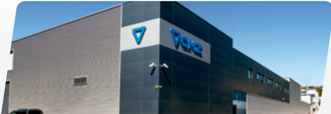
Montagewerk für CNC Drehmaschinen 5.500 m 2 | Zaldibar – Spain
