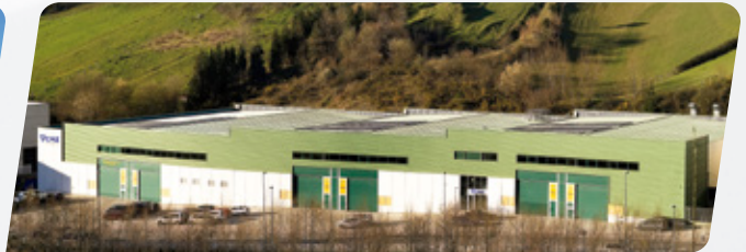
Montagewerk für CNC Drehmaschinen 10.000 m 2 | Mallabia – Spain
