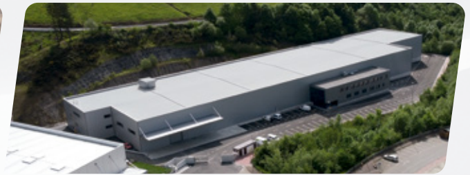
Neue Fertigungsstätte 10.000 m 2 | Mallabia – Spain
